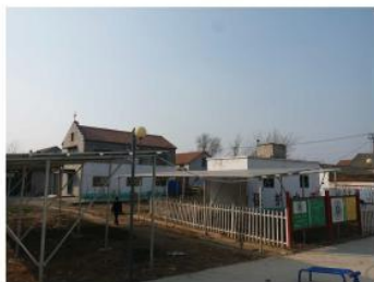
谷亭街道八里湾村光伏发电
